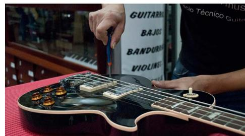
Damos comienzo entonces con la parte de ajuste ya con las cuerdas nuevas puestas, arrancando con el ajuste de la curvatura del mástil y por tanto el ajuste del alma. Esta es una pieza que se encuentra en el interior del mástil y que sirve para ayudarnos a ajustar los posibles movimientos que pueda tener el mástil debidos a la tensión que generan las cuerdas sobre él.
